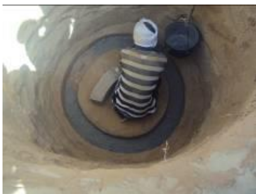
Pose du béton de propreté
