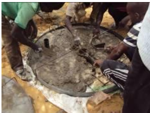
Coulage d'une dalle
